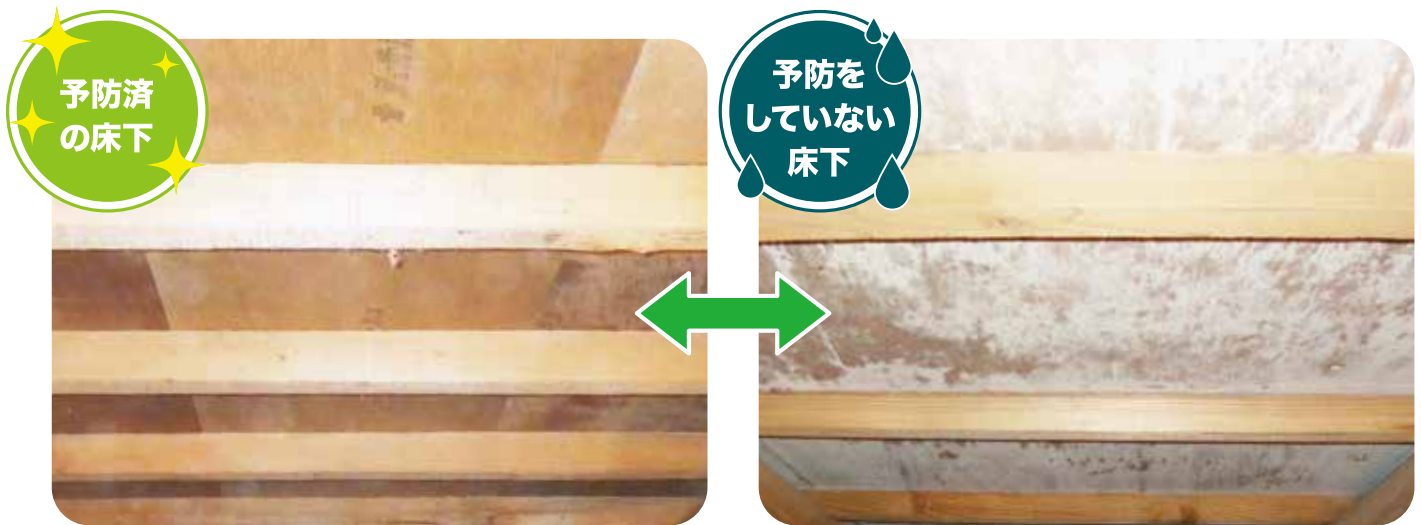
JIS K 1571:2010(木材保存剤-性能基準及びその試験方法)に記載の表面処理用木材保存剤にかかる性能基準に適合。
